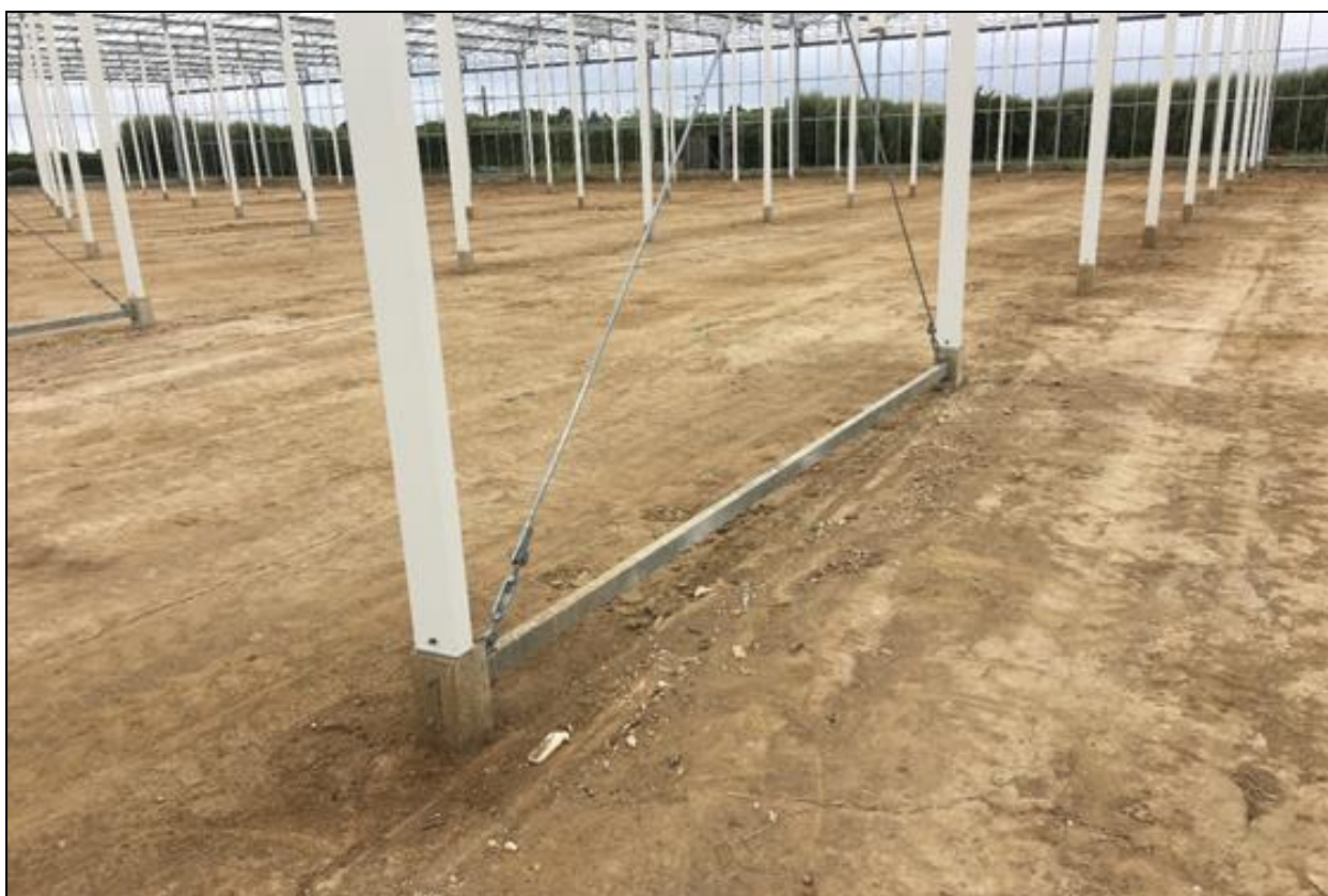
Figure 4 : Photographie du terrassement des serres existantes
