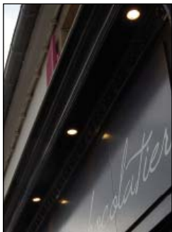
Il est toujours préférable de prévoir une corniche saillante sur le haut des devantures en applique. Elle protège des salissures (coulores d'eau) et permet d'intégrer des spots encastrés.
