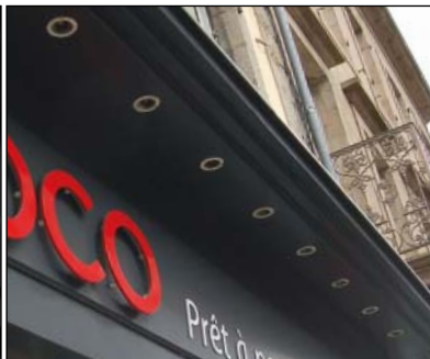
Il est toujours préférable de prévoir une corniche saillante sur le haut des devantures en applique. Elle protège des salissures (coulores d'eau) et permet d'intégrer des spots encastrés.
