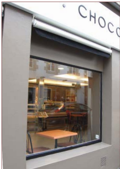
Ce store, qui s'encastre parfaitement dans le tableau de la vitrine permet de bien remplir sa fonction de protection (soleil ou intempérie) quand c'est nécessaire, et n'obscurcit pas l'intérieur quand il est replié.
