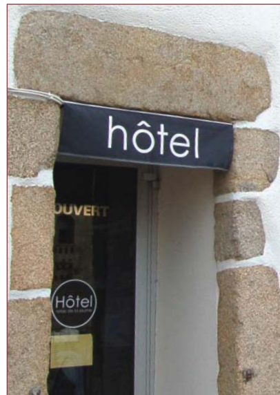
Les lambrequins permettent un marquage discret et élégant. Ils peuvent être en toile (photo), mais aussi en bois peint ou métal, ouvragé ou non, comme c'était le cas traditionnellement. Une inscription soignée complète l'enseigne.
